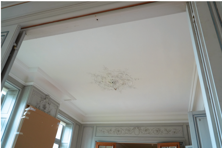
Le plafond du salon des académiciens avec ouvertures, puis repeint.
