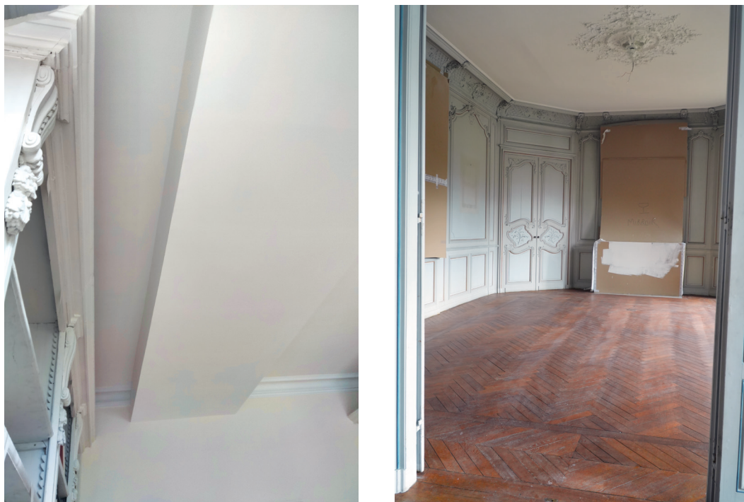
Le plafond de la salle des archives au 2 e étage et le salon académiciens après travaux.
